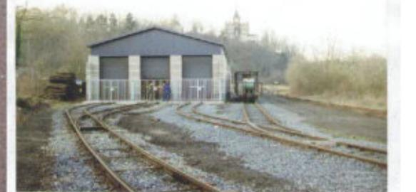
La voie 11 de l'atelier (à droite) est raccordée et une voie IV (garage lateral) posée (RDD 0206)
